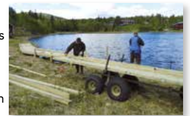
Byggnation av rampen under 2018.
